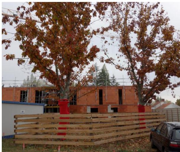
Figure 2 : Exemple de barriérage pouvant être mis en place en phase chantier pour préserver les arbres existants
