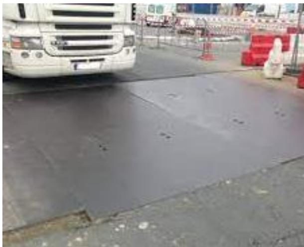
Figure 1 : Exemple de plaques béton permettant le décaissement des sols
