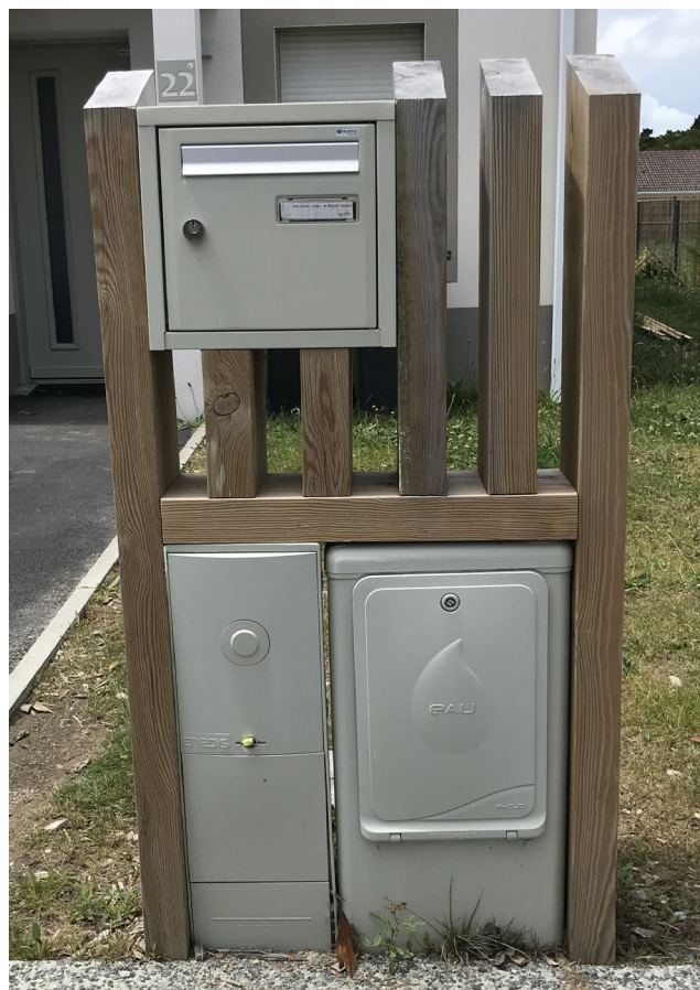
Exemple de réalisation
