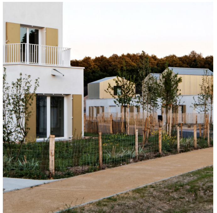
Poteaux châtaignier et grillage galvanisé
